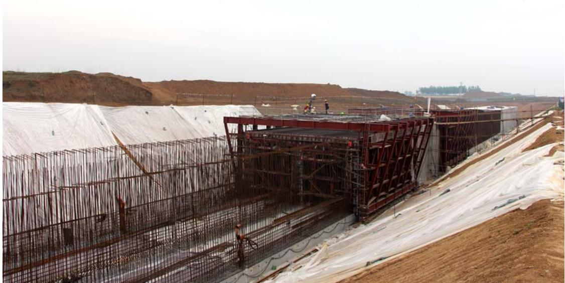
2016年4月12日凌晨5点，鄂北调水工程3标首次成功使用钢模台车浇筑暗涵墙身及顶板混凝土，一次完成混凝土 $334.5\text{m}^3$ 。
